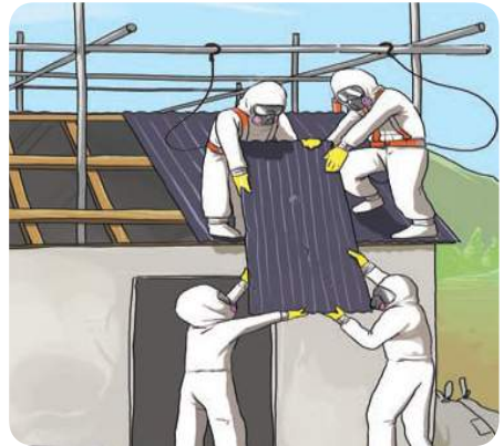
비계·안전고리 설치 및 페슬레이트 안전제거
