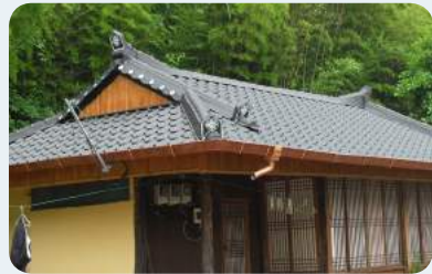
슬레이트 철거·지붕 개량 후
